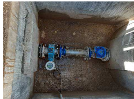
Débitmètre électromagnétique Trop-plein PR Maucoulet
